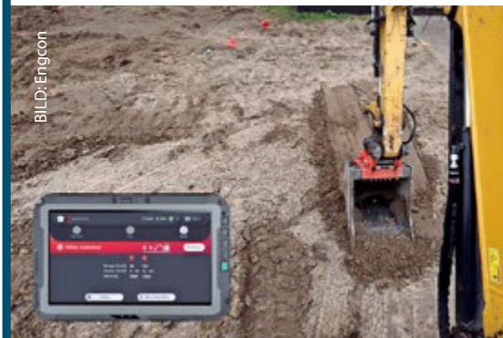
Unterirdische Leitungen beim Baggern in Echtzeit erkennen – dies ermöglicht das mit Engcon-Produkten kompatible LDR-System von RodRadar.
