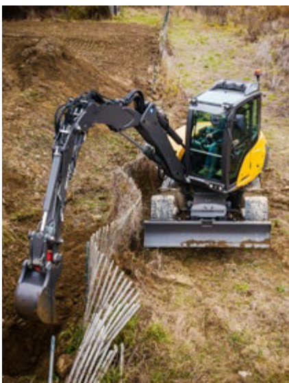
Zusätzliche Freiheit bietet der Mecalac 9MWR, der mit seitlichem Auslegerversatz auch außerhalb des Maschinenmusters im „Offset-Modus“ arbeiten kann.
